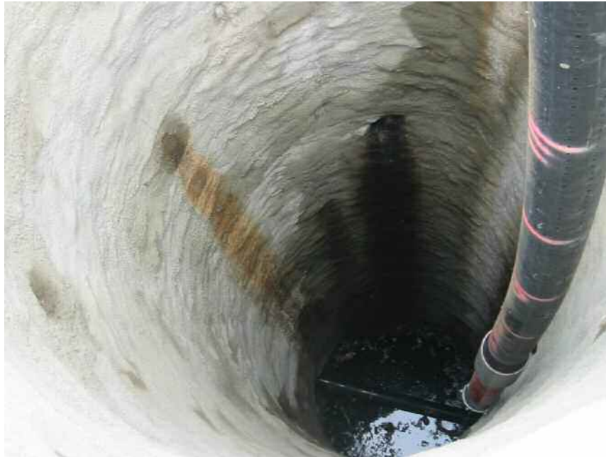
Abbildung 1 Einfahrt des Aufweitkörpers über den Startschacht in den Rohrleitungskanal
