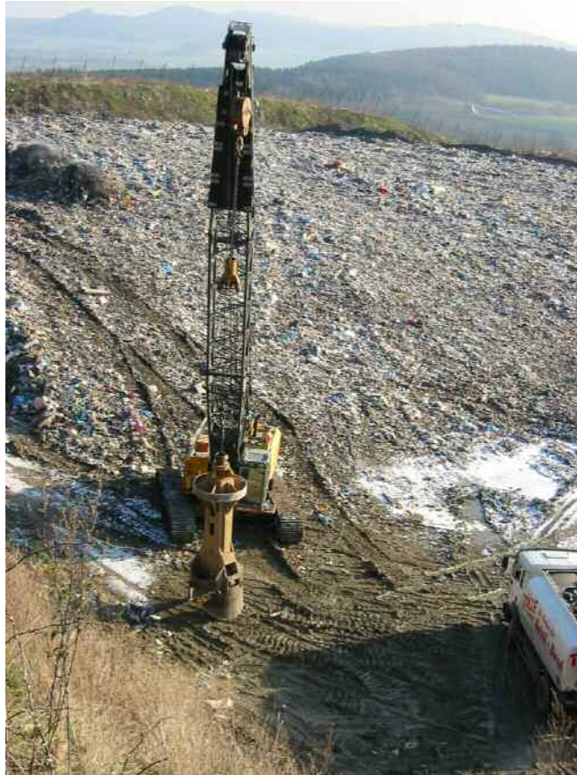
Abbildung 3 Trockenbohrgerät mit Bohrwerkzeug
